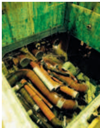
Sotto una fase dello smantellamento della centrale di Caorso
